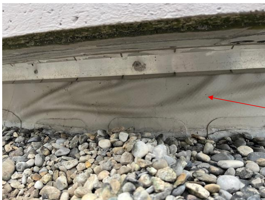
Etanchéités sur édicules à traiter
